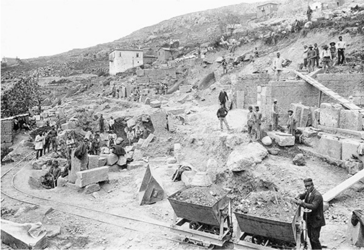
FIGURA 13.1. La excavación a pleno rendimiento, con las vías y las vagonetas en uso para despejar la entrada al santuario de Apolo (© EFA [La redécouverte de Delphes, fig. 77]).
